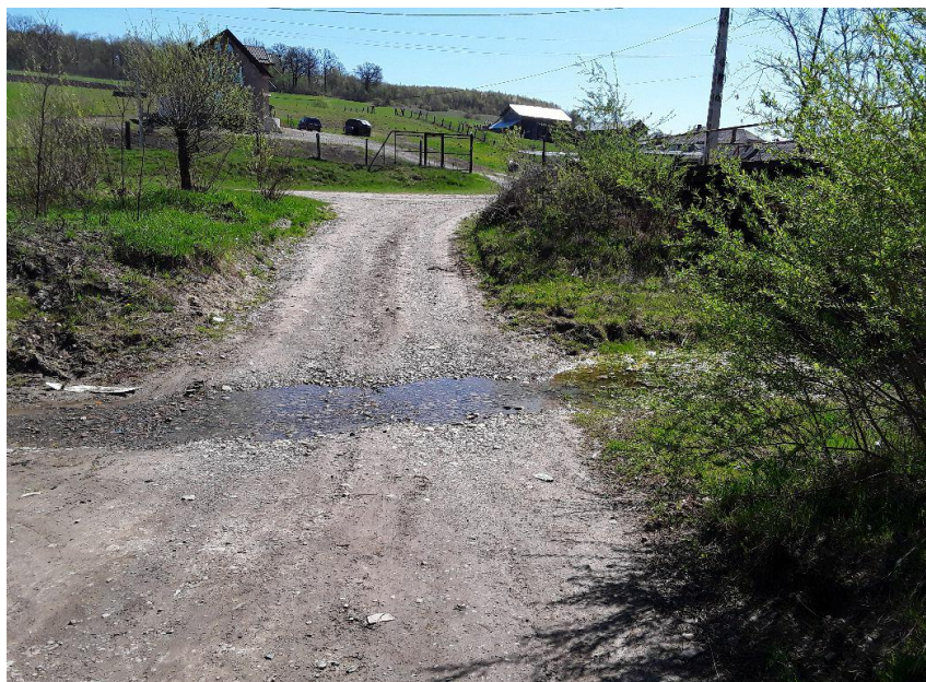
Fig. 28 Drum secundar – str. Paraului, cu trecere peste paraul Tolici
